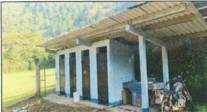
Foto 10: Ampliación de servicios sanitarios debido a la falta de los mismos, asi como la instalación de tinaco para captación y distribución de agua.
