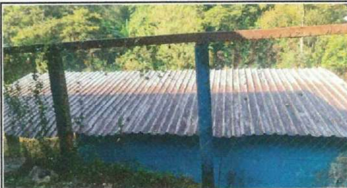
Foto 8: Mejoramiento de cubierta de lamina y estructura en servicios sanitarios, debido al deterioro de la misma.
