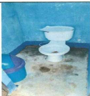
Foto 9: Mejoramiento de servicios sanitarios y sus accesorios debido al mal estado de los mismos, asi tambien como la instalación de piso antideslizante.
