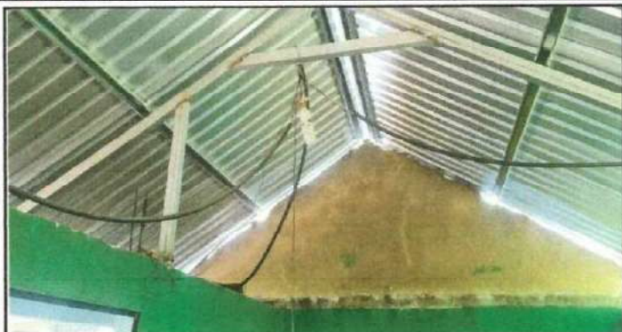
Foto 7: Mejoramiento red de sistema electrico principal en aulas, dirección y cocina debido a la sobrecarga y mal estado.
