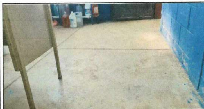
Foto 3: Instalación de piso cerámico en dirección debido al deterioro y mal estado de torta de concreto.
